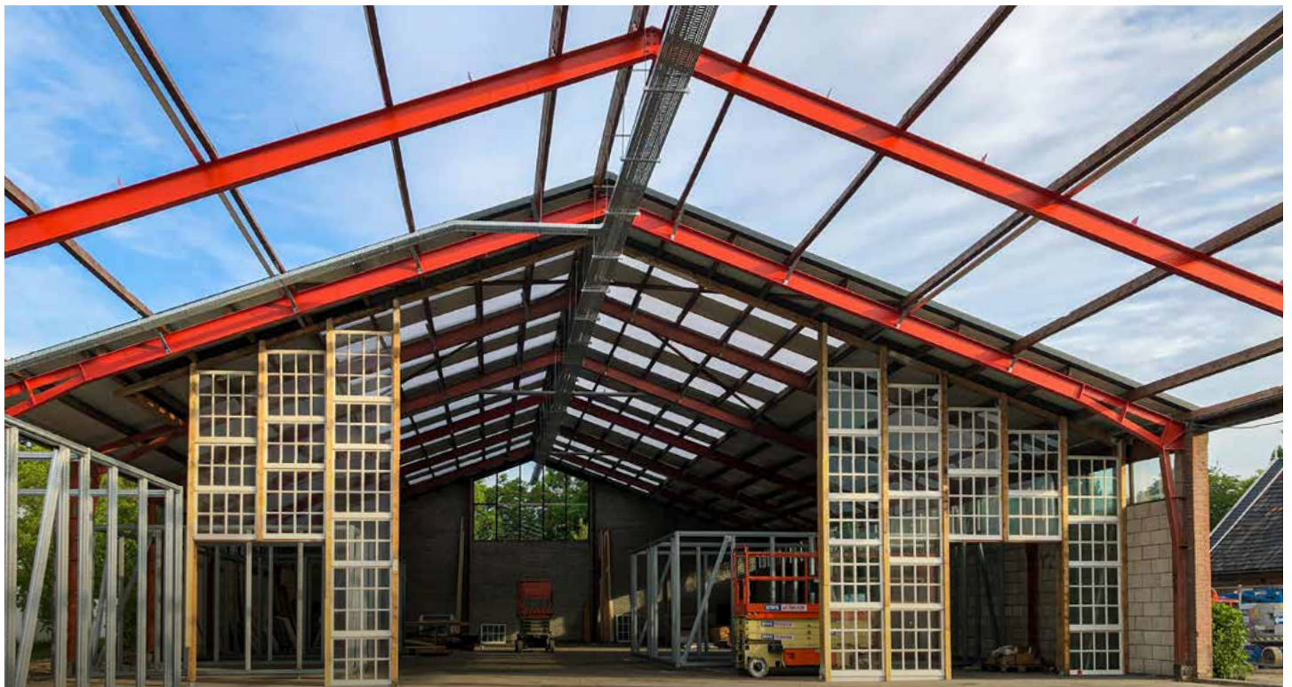
Bij de realisatie van het circulair paviljoen C Bèta hebben we Skellet profielen toegepast voor de constructie van de huurunits in het gebouw. Deze profielen kunnen, wanneer de units aan het eind van hun levensloop zijn, weer opnieuw in nieuwe constructies worden gebruikt.
